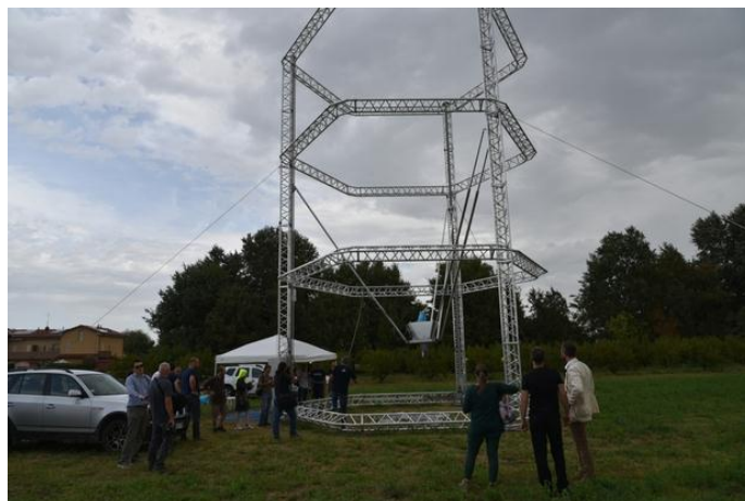
Рис. 4. Строительный роботизированный комплекс The BigDelta
