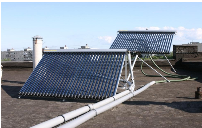
Рис. 3. Экспериментальная система УкрГГРИ для нагрева воды с использованием солнечных коллекторов
